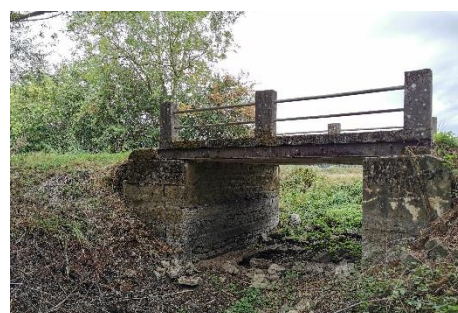
Pont chemin de Sens
