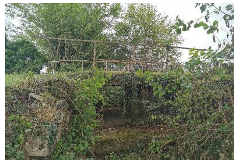
Pont entrée bois - Suligny « Les Veney »
