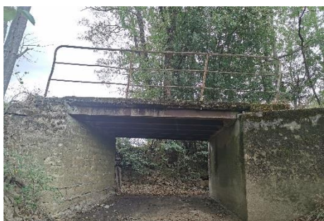
Pont de la Boissine Vers Montcony
